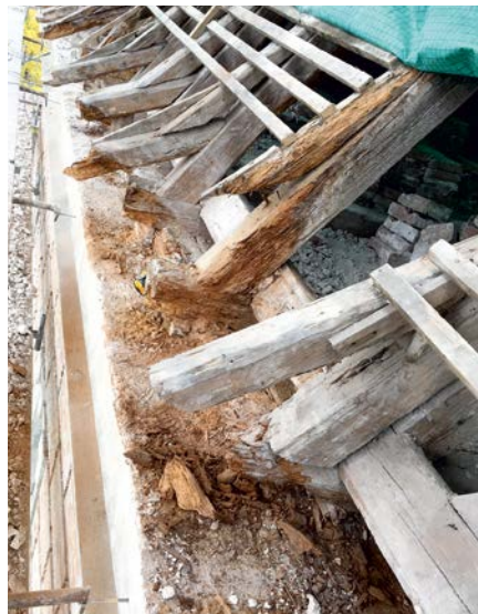
Große Schäden im Holz des Pfortenhauses: Mauerbank und Gesimse mussten erneuert werden.
