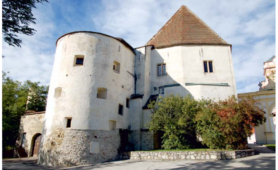
Fassade und Dach der mittelalterlichen Burg werden renoviert.
