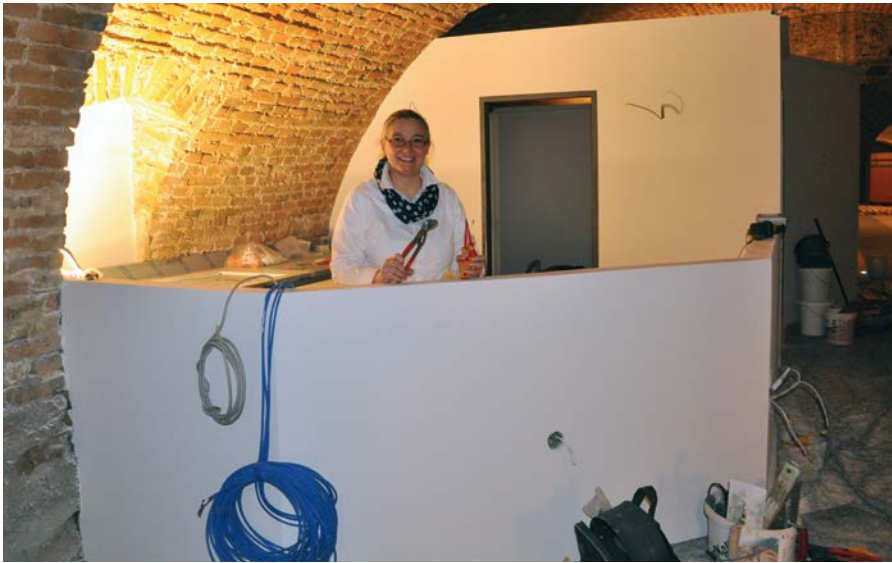
Eveline Gruber, Leiterin des Tourismusbetriebes, überzeugt sich vom Baufortschritt.
