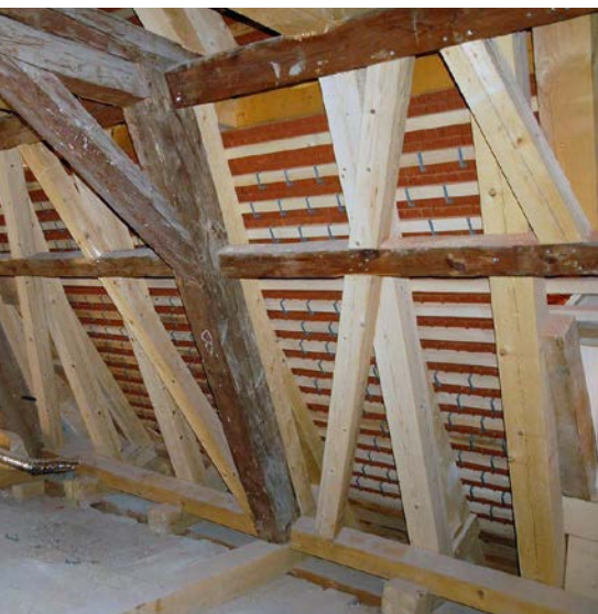
80 Prozent schadhafte Holz wurde erneuert.
