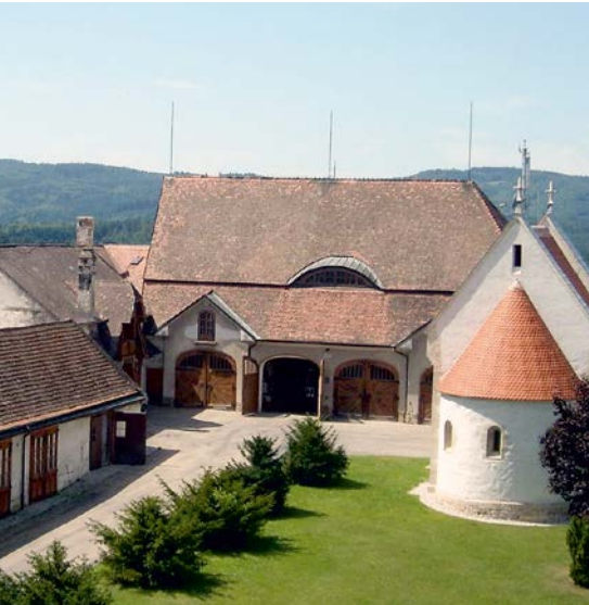
Die Dachstühle über den Werkstätten werden instand gesetzt.
