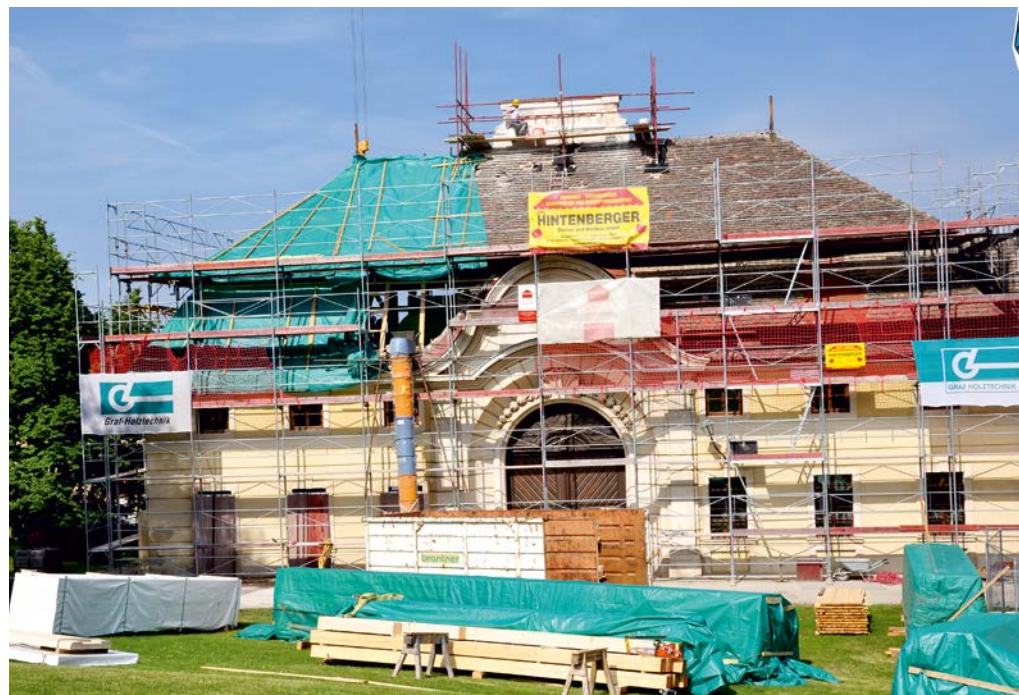
Das Pfortenhaus während der Arbeiten
