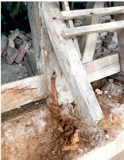
Große Schäden im Holz des Pfortenhauses: Mauerbank und Gesimse mussten erneuert werden.
