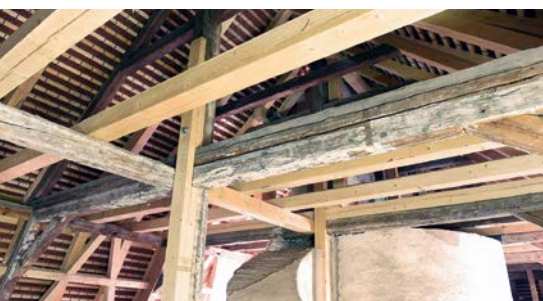
80 Prozent schadhafte Holz wurde erneuert.
