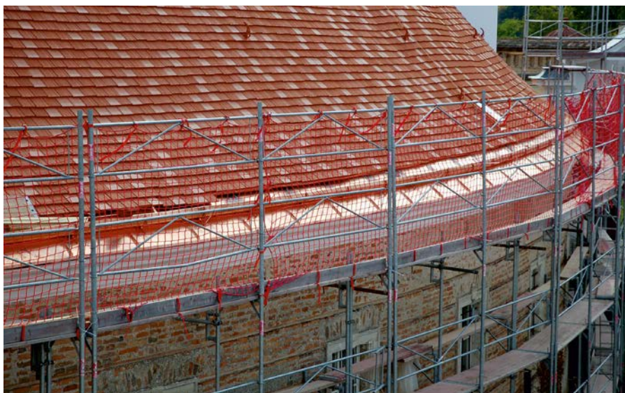
Kupferblech schützt die neue Mauerbank und das neue Gesimse des Pfortenhauses.
