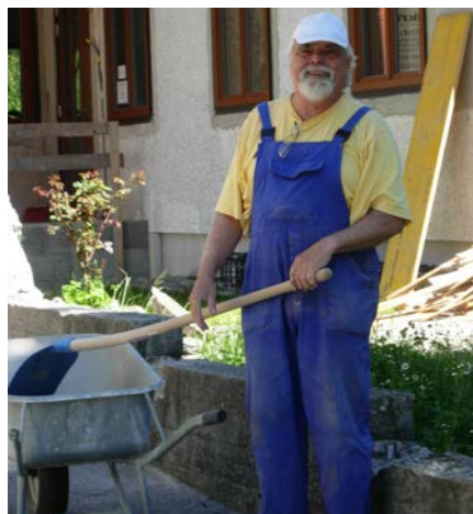
Umbau des Pfarrzentrums
